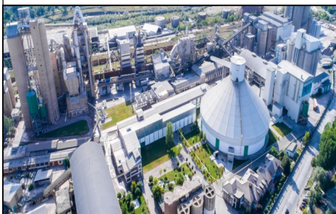
Fabrica de ciment – Fieni
